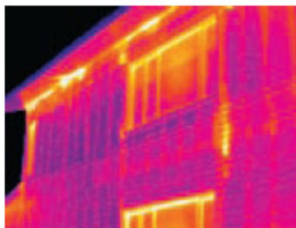
La termografia può essere utilizzata per verificare eventuali fuoriuscite di calore da un edificio attraverso le finestre, i cornicioni o le pareti con isolamento insufficiente.
